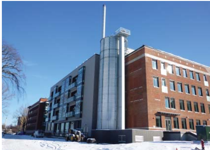
Le silo contient 450 m 3 de granules de bois, une réserve pour six semaines pour l'utilisation régulière en hiver
