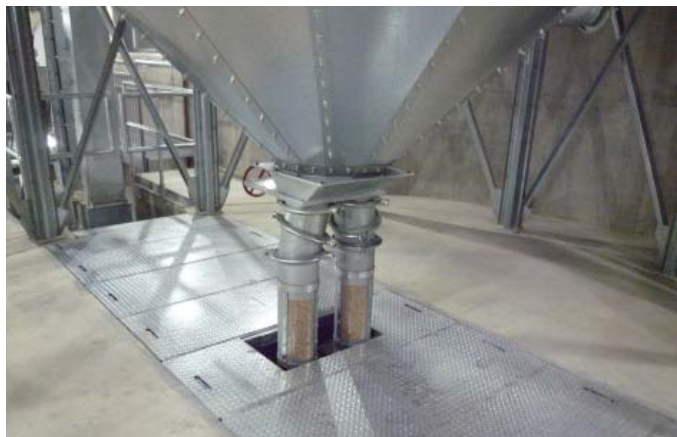
Alimentation en granules de bois par deux mécanismes d'alimentation indépendants pour les chaudières Pyrotec
