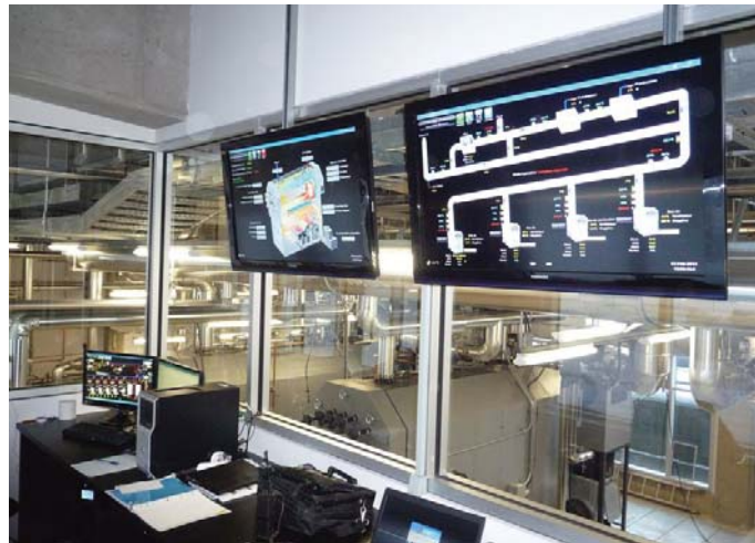
Deux écrans aident à illustrer le système de chauffage à distance aux visiteurs. Écran droit : données Pyrotec des dispositifs de commande Viessmann. Écran gauche : données des circuits de gaz de combustion et d'échangeur thermique
