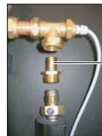
Connection isiclick® au capteur
