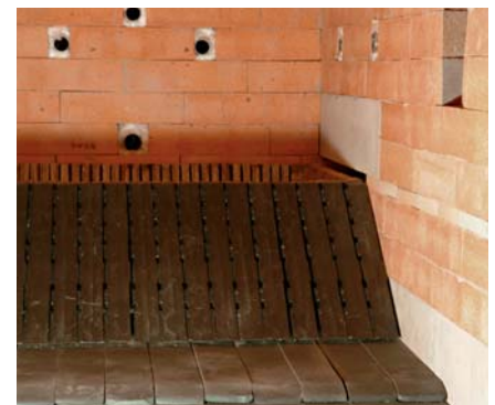
Chambre de combustion enduite de brique réfractaire avec grille externe et grille mobile interne.
