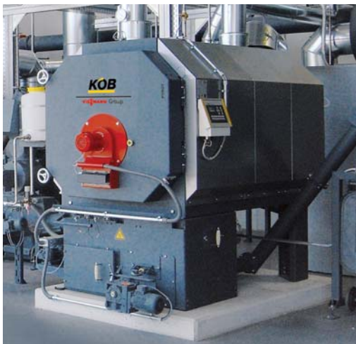
Chaudière Pyrot avec goulotte de décentrage et contenant à cendre externe
